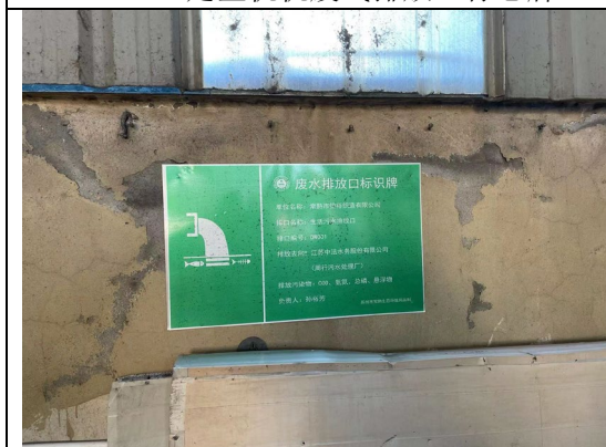
生活污水排放口标志牌
